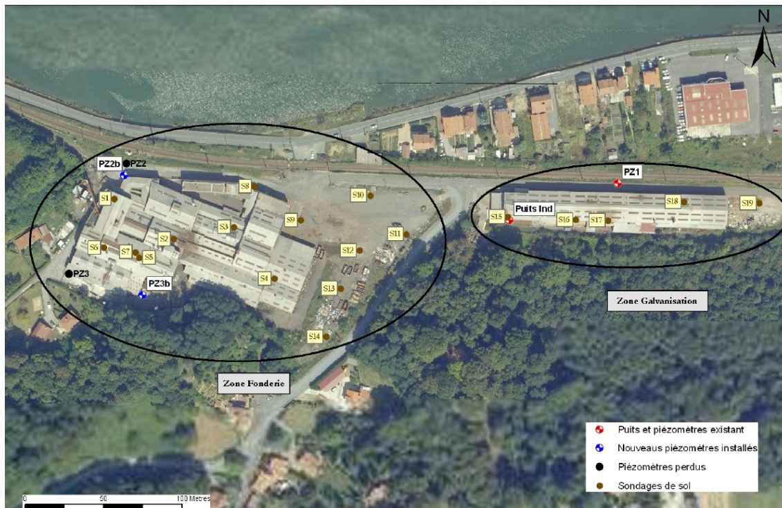
Investigations menées par TERE0 en novembre 2008 (source : rapport TERE0, déc. 2008)
